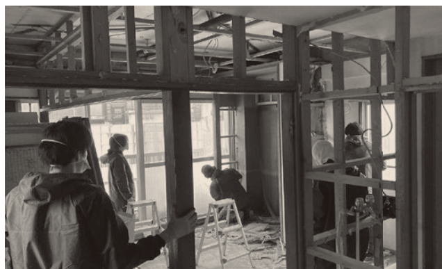
解体作業 2022年3月 photo: 神村恵
