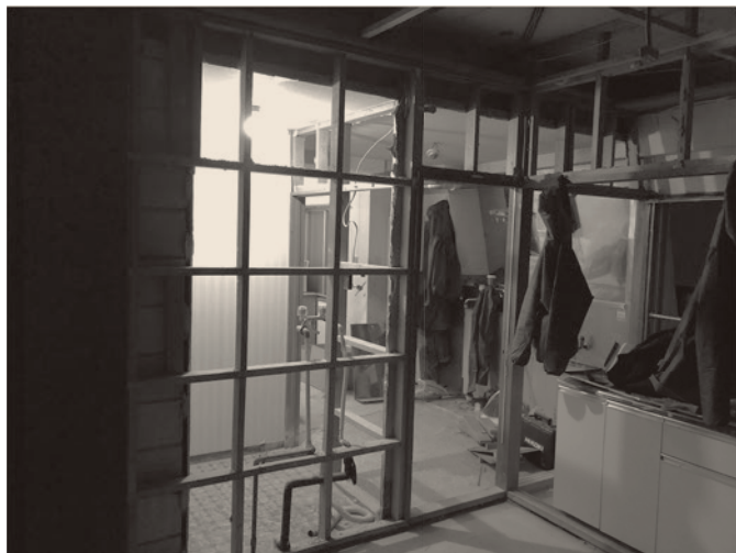
解体途中の現場 2022年3月 西国分寺スタジオプロジェクト photo: 神村恵
